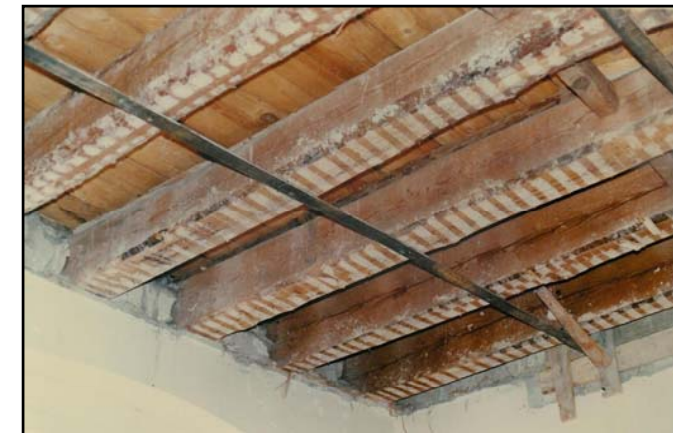
Legatura dei solai alle murature perimetrali
